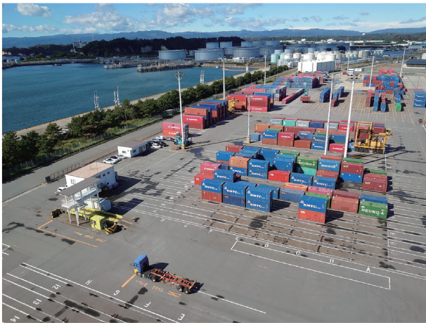
コンテナヤード
